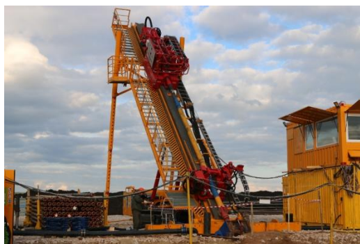
Рисунок 2 – Буровая установка ГНБ НК250С-SDD
